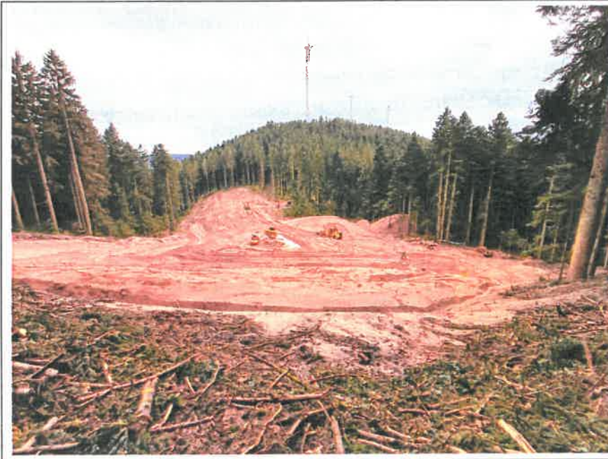
Abb. 4: Windradbaustelle im Schwarzwald (bei Schapbach auf dem Kup- ferberg), Juli 2024. Die Rodung erstreckt sich auf eine Länge von 500 m und ist 80 m breit. Die Bagger in der Bildmitte lassen den Umfang erah- nen.
