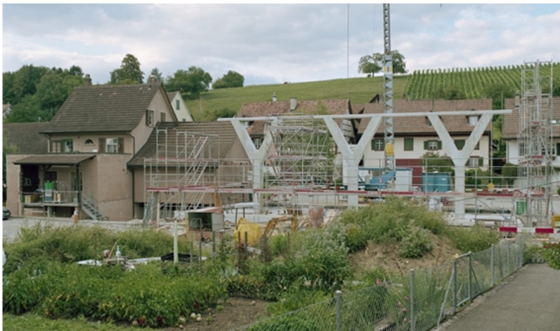
Die Anbauten beim alten Volg wieder rückgebaut, die ursprüngliche Gartenanlage jedoch nicht.
